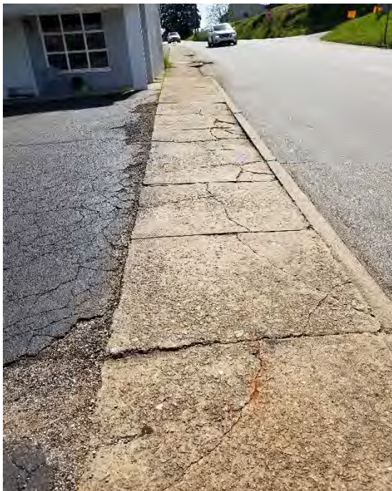
Spalling
